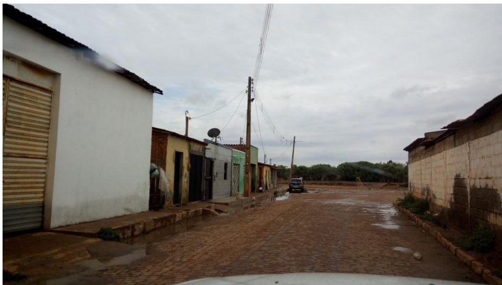
Figura 183 – Ponto de alagamento na Sede Municipal
