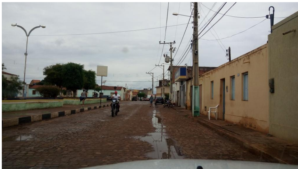
Figura 178 – Ausência de dispositivos de microdrenagem - Via com pontos de alagamentos
