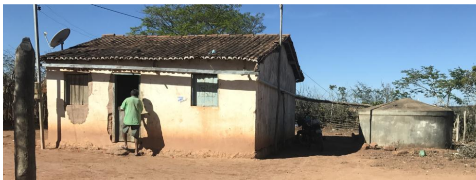
Figura 72 - Sistema de coleta de água do telhado – Mulungu do Morro
