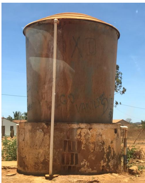
Figura 111– Reservatório de água salobra – Espia/Mulungu
