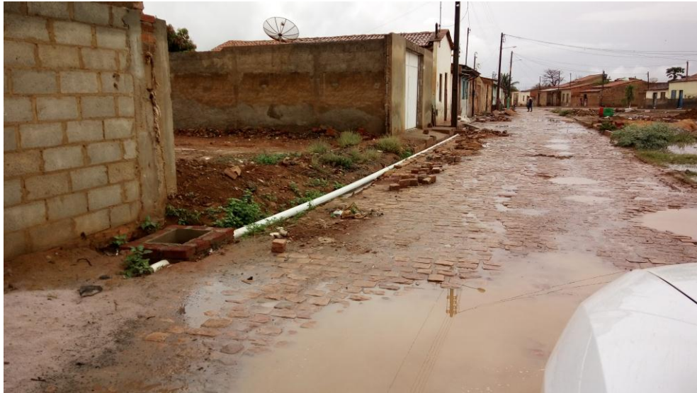
Figura 185 – Ponto de alagamento na Sede Municipal
