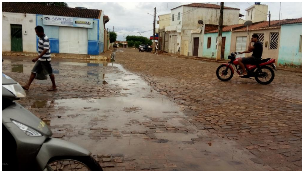
Figura 174 – Tipo de pavimentação no município de Mulungu do Morro: Calçamento poliédrico
