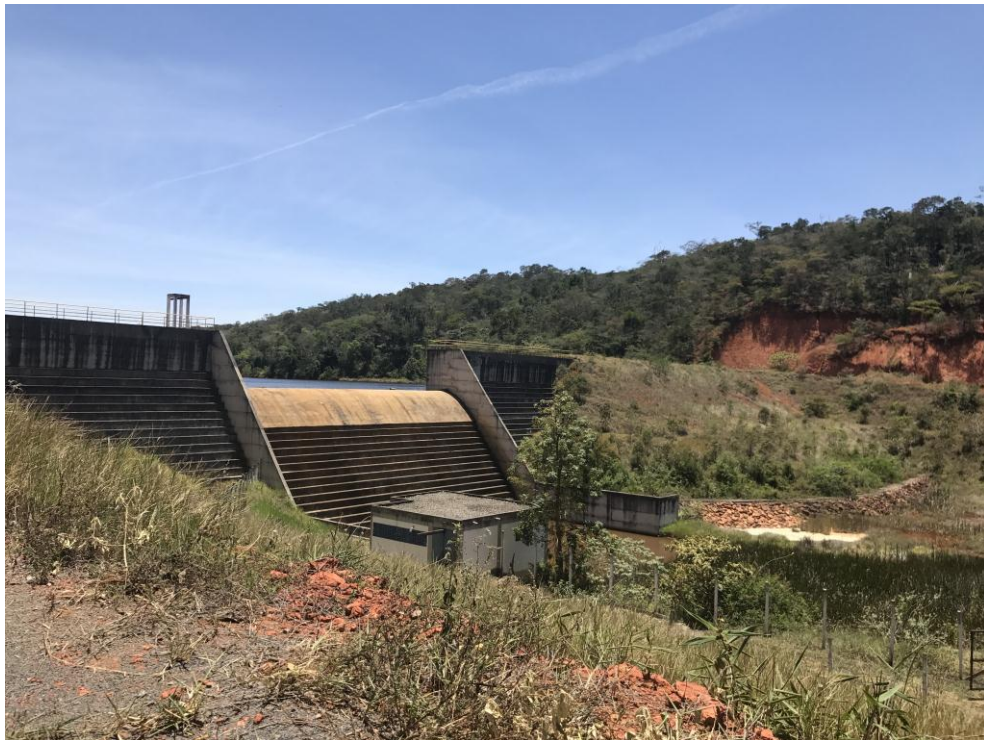
Figura 59– Barragem de Rio Tijuco
