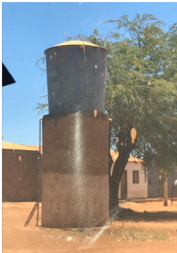
Figura 81 – Reservatório de água salobra – Rosendo/Mulungu
