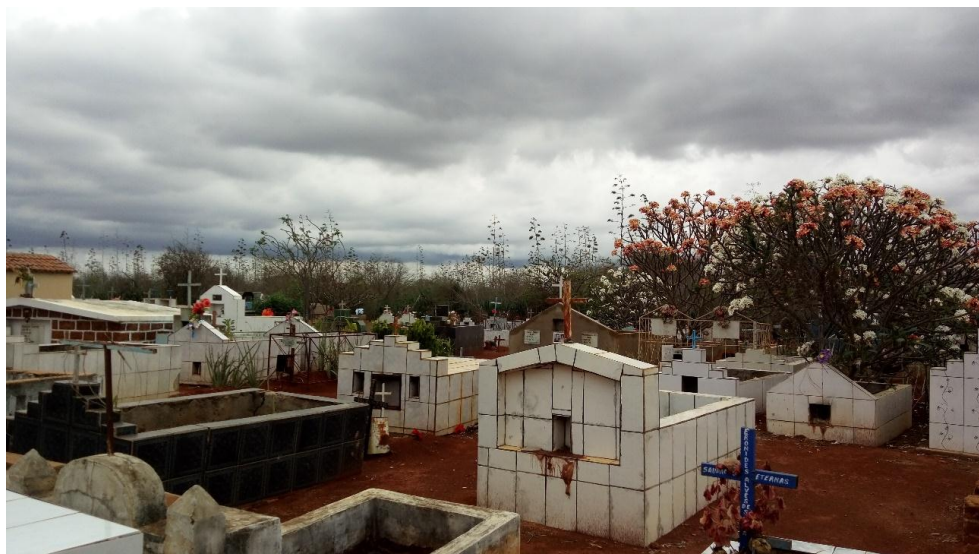
Figura 151 – Interior do cemitério da sede do município de Mulungu do Morro Fonte: Projeta Engenharia (2017)
