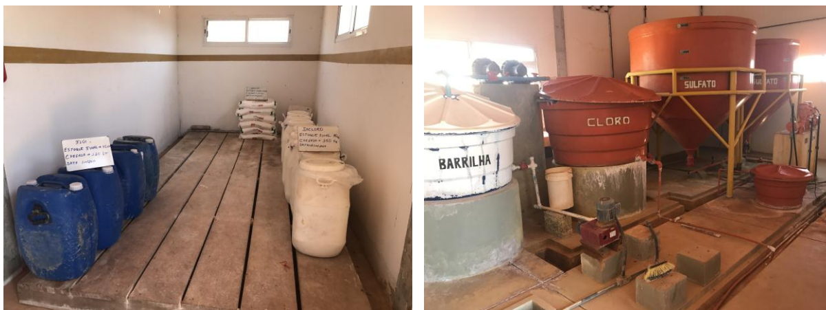
Figura 63 – Casa de química da ETA- Mulungu e Souto Soares
