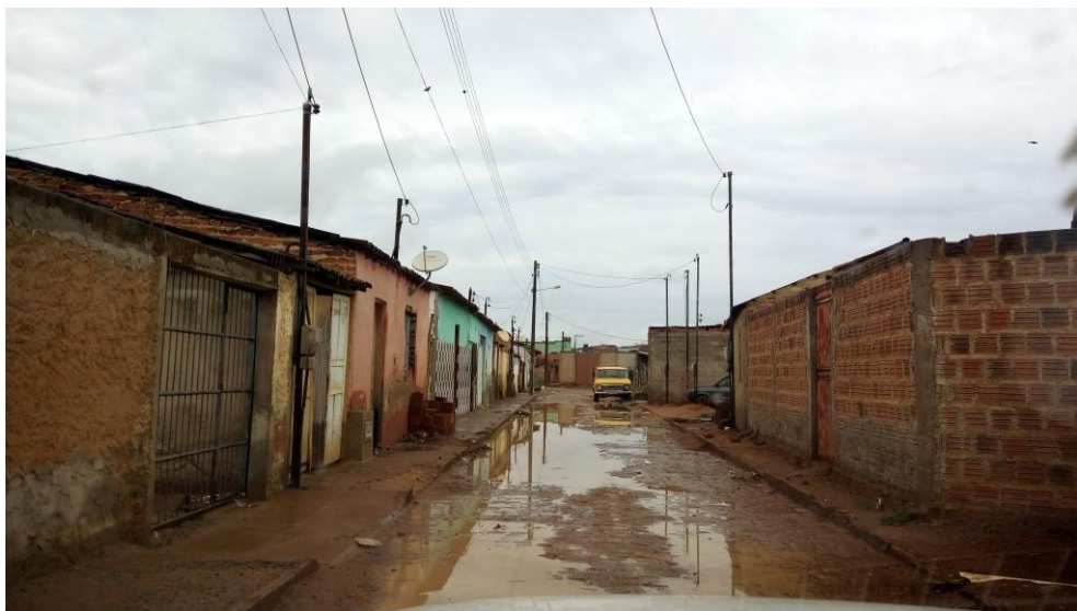
Figura 186 – Ponto de alagamento na Sede Municipal
