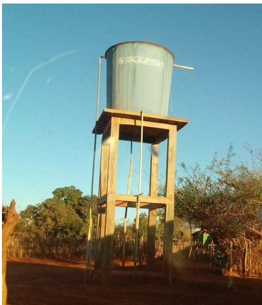
Figura 100 – Reservatório de água salobra - Lagoa Nova/Mulungu
