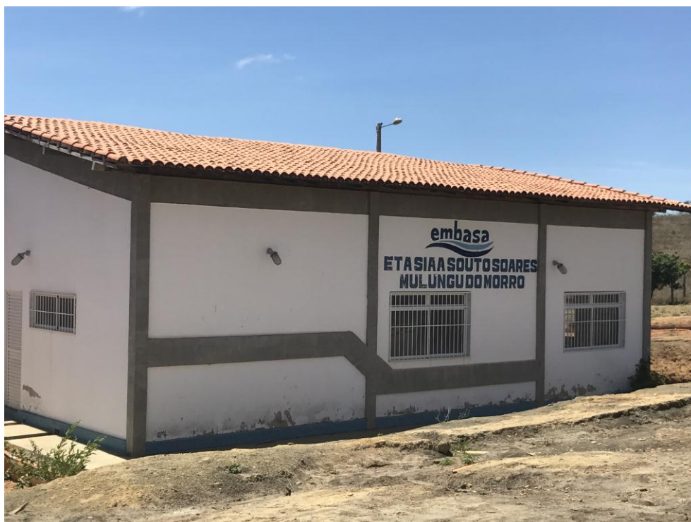
Figura 62– Estação Tratamento de Água Bruta-ETA Mulungu e Souto Soares
