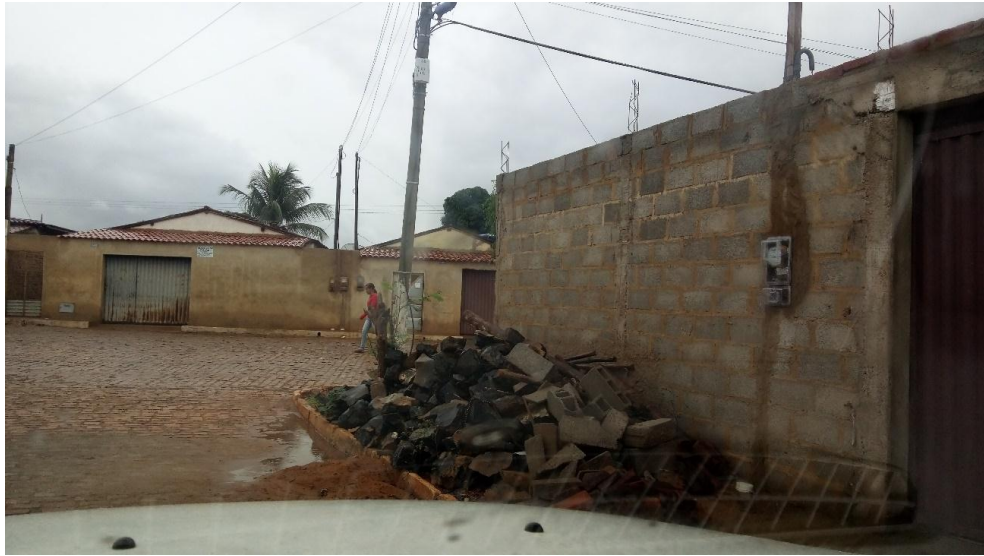
Figura 138 – RCC gerado em obras na sede do município de Mulungu do Morro
