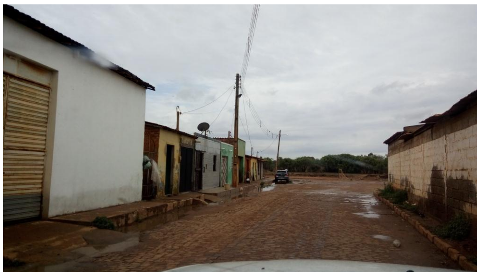
Figura 179 – Ausência de dispositivos de microdrenagem - Via com pontos de alagamentos
