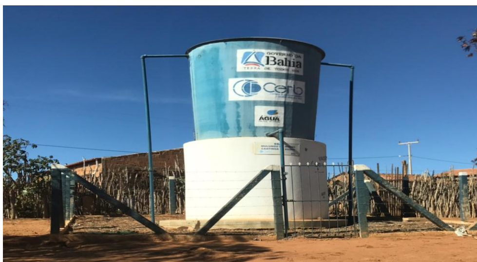
Figura 90– Reservatório de água doce – Caatinga do Egídio/Mulungu
