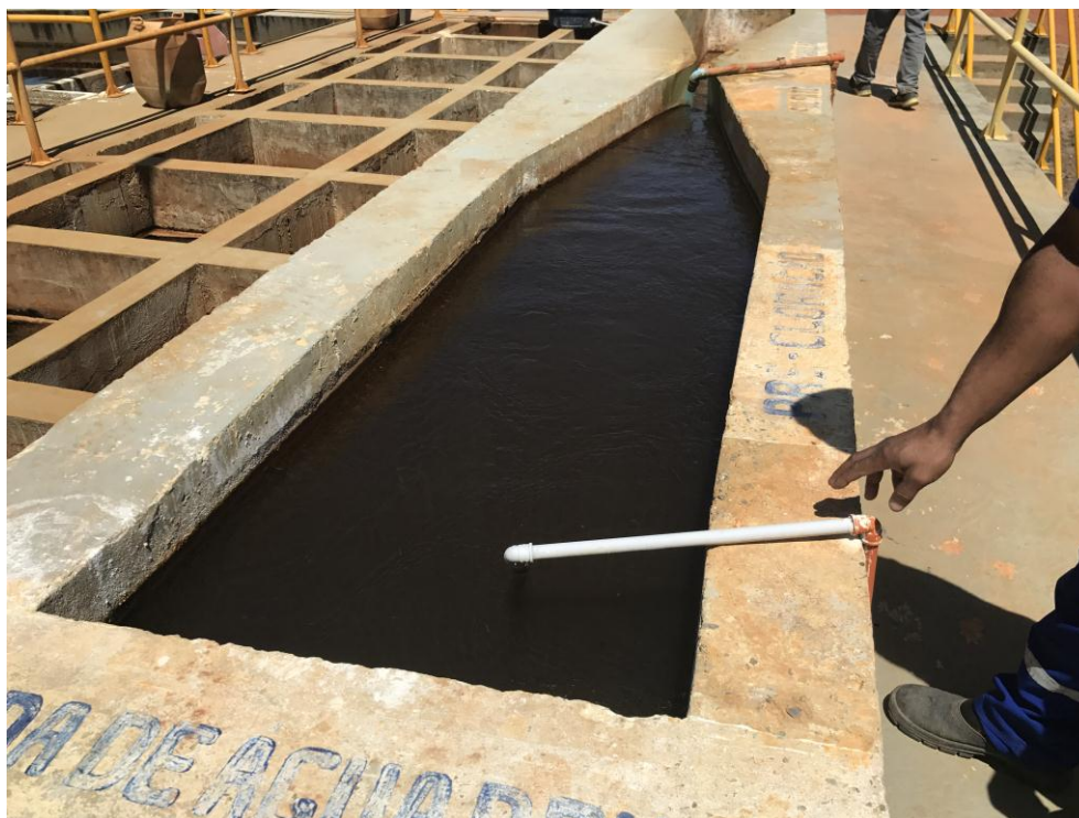
Figura 64 – Entrada de água bruta
